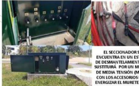
EL SECCIONADOR SE ENCUENTRA EN UN ESTADO DE DESMANTELAMIENTO, SE SUSTITUIRÁ POR UN MURETE DE MEDIA TENSIÓN (M-5A ) CON LOS ACCESORIOS PARA ENERGIZAR EL MURETE M-13
