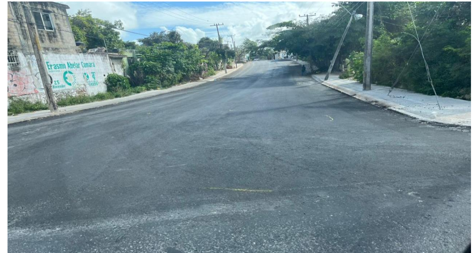
REHABILITACIÓN DE PAVIMENTO, MUNICIPIO DE BENITO JUÁREZ, LOCALIDAD DE CANCÚN, QUINTANA ROO, CALLE 19 ENTRE AV. PUERTO JUÁREZ Y AV. JOSÉ LÓPEZ PORTILLO
