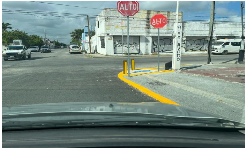
REHABILITACIÓN DE GUARNICIONES Y BANQUETAS EN EL MUNICIPIO DE BENITO JUÁREZ, LOCALIDAD CANCÚN, QUINTANA ROO, CALLE 19
