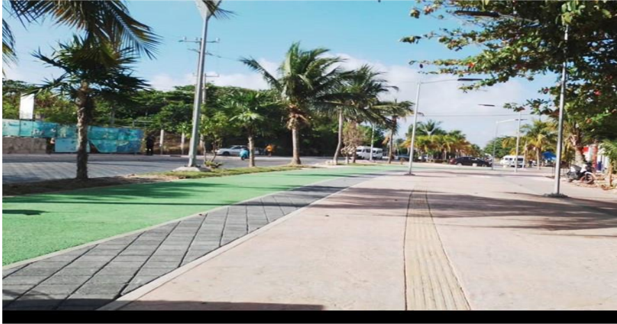
CONSTRUCCIÓN DE CICLOVÍA, MUNICIPIO DE BENITO JUÁREZ, LOCALIDAD CANCÚN, QUINTANA ROO, AV. CHAC MOOL
